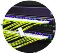
C'est un fil en verre ou en plastique très fin qui a la propriété d'être un conducteur de la lumière et sert dans la transmission de données et de lumière. Elle est utilisée pour connecter les serveurs et les commutateurs pour sa rapidité de transmission du signal.
